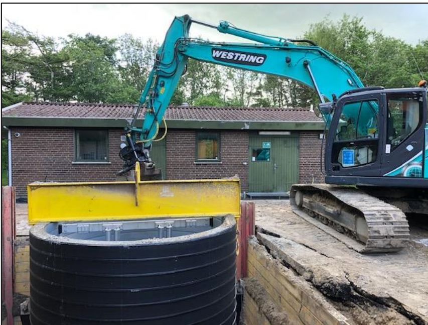
Udsholt pumpebrønd er nu sat, den sidste af de tre renseanlæg.
