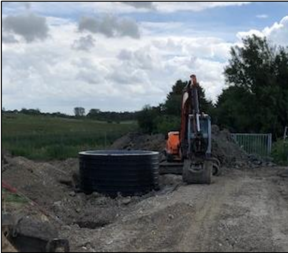
Tulstrupvej pumpebrønd sat
