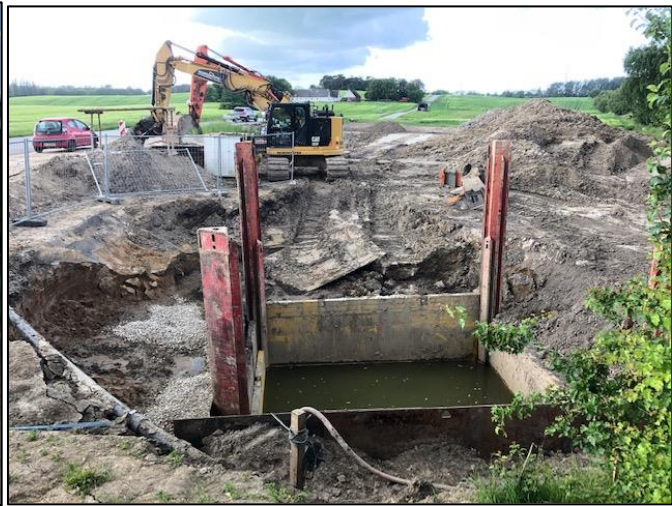
Bøgebjergvej udgravning til pumpebrønd
